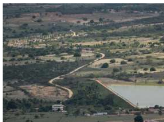
Figura 3 - Região do açude DNOCS
